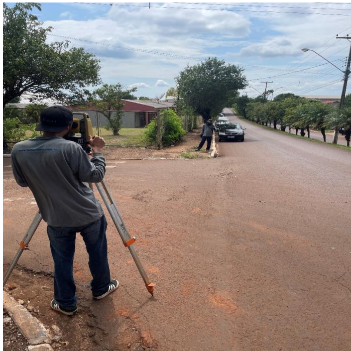
Figura 02: Estação Total operando na data do levantamento
