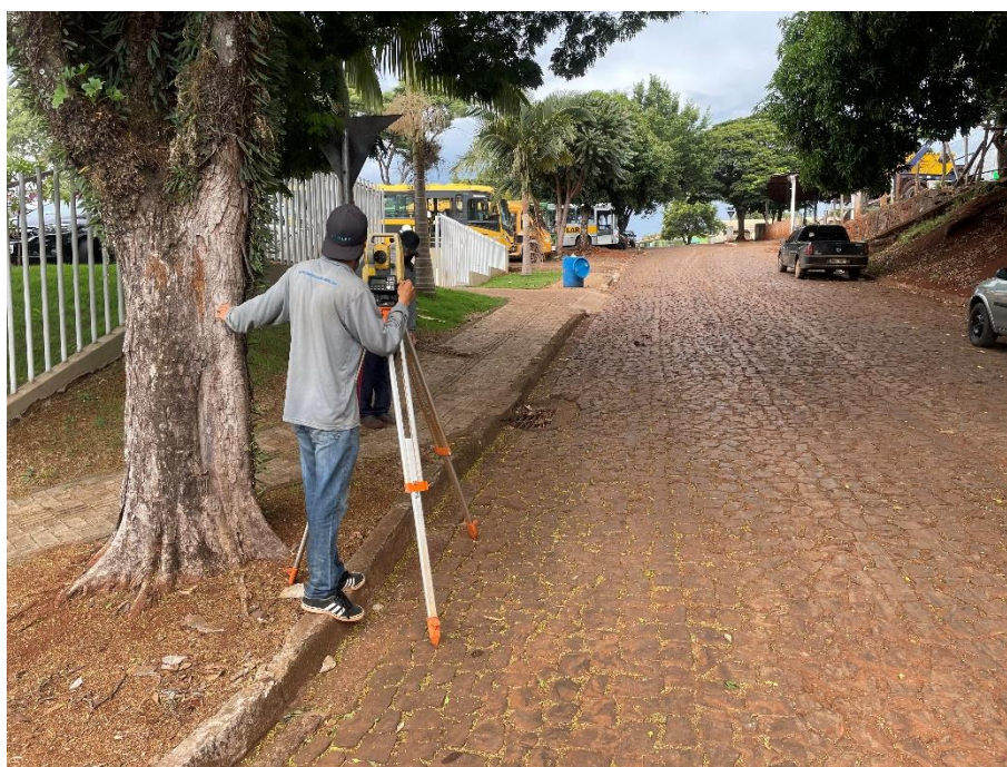
Figura 03: Estação Total operando na data do levantamento
